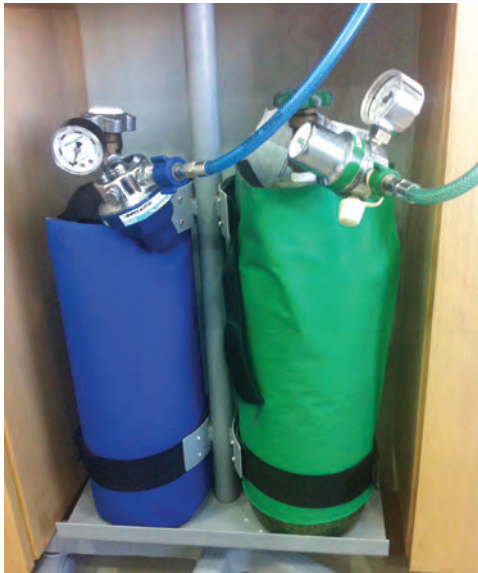
Figura 1 – Cilindros de oxigênio e óxido nitroso com suas cores de seguranças
